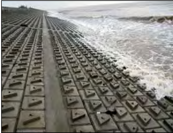
Hình 6. Đê chắn sóng biển
